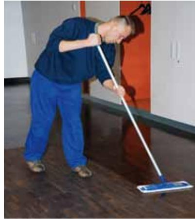
Im Versiegelungsverfahren wird 1-3 mal ein Spezialmittel aufgebracht, eine Kombination aus Porenfüller und Pflegeöl.
