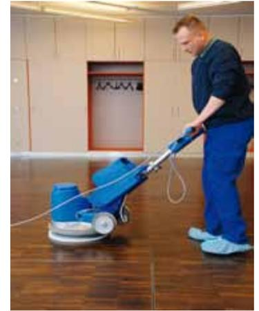
Nach der erfolgten Durchtrocknung der Beschichtung erfolgt ein intensives Auspolieren des neuen Pflegefilmes.
