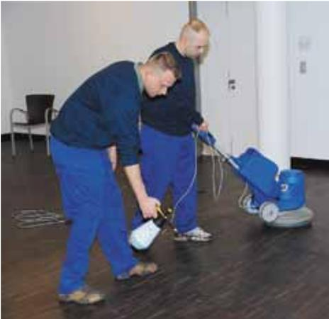
Das 3-stufige Verfahren beinhaltet eine intensive Tiefenreinigung mit einer Scheibenmaschine, also die Entfernung von Alt-Pflegemitteln sowie Schmutz, Belägen und Flecken.
